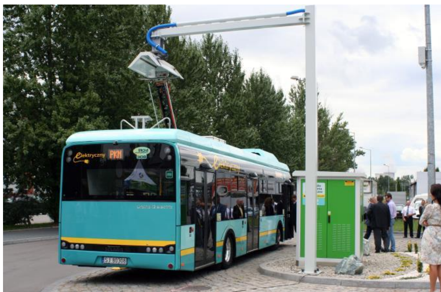
Rysunek 9: Pantografowa stacja ładowania autobusów elektrycznych w Jaworznie, źródło: https://www.transport-publiczny.pl/img/jaworznostacja1.jpg_678-443.jpg
